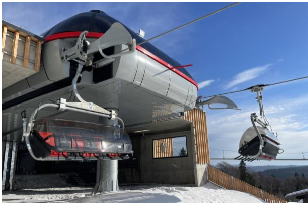
Bild 2: Beeindruckende Anlage: die neue 6er Sesselbahn am großen Almberg © FNBW, Wagner
